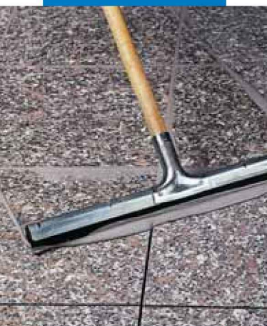
Fogning av glaserade plattor med gummiraka
