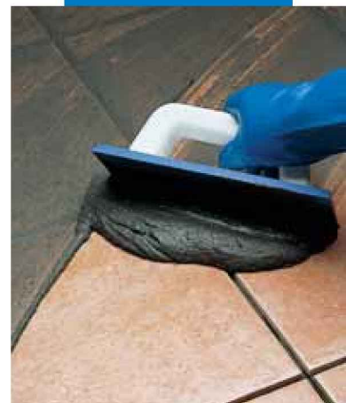
Fogning av enkelbrända plattor
