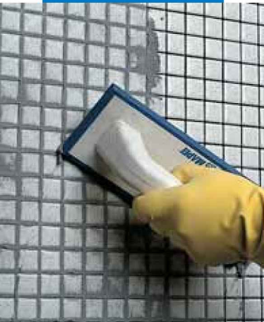
Fogning av glasmosaik med gummispäckel
