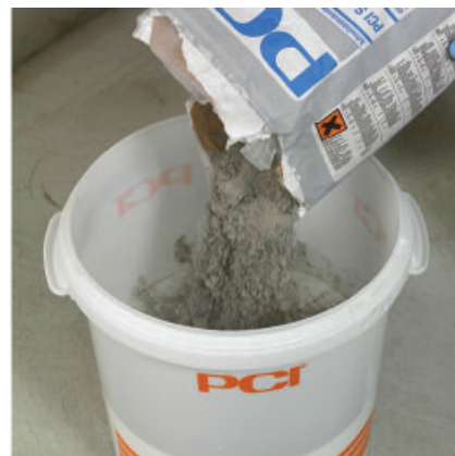
Tillsätt PCI Seccoral 2K Rapid-bruk.
