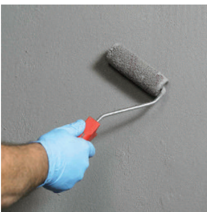
Stryk på första skiktet heltäckande med t.ex. roller eller pensel.
