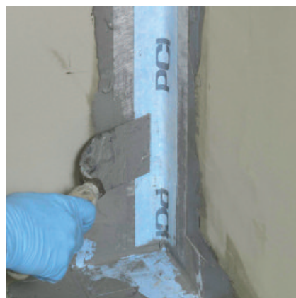
Täta med tätremarna PCI Pecitape i hörnen.
