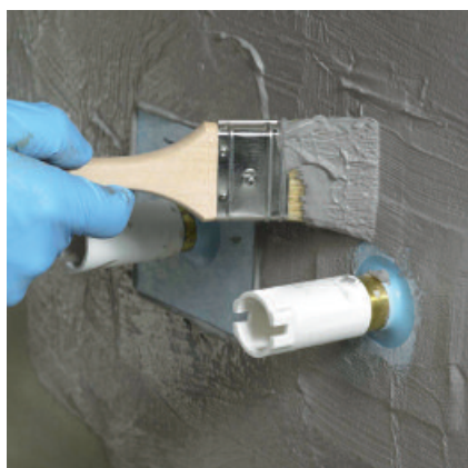
Förankra tätmanschetterna PCI Pecitape 10,5x10,5 (Ø10-24).
