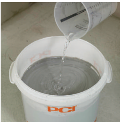
För strykning, tillsätt rätt mängd vatten (1 b).
