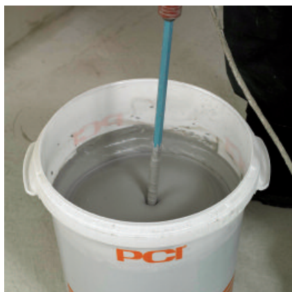
Blanda PCI Seccoral 2K Rapid för spackling (1 a) till en slät massa.
